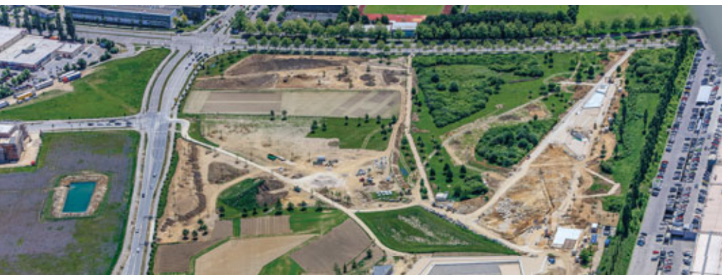
Gelände der LGS während der Bauarbeiten
