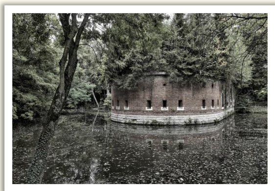
Künettegraben, von der Schutter durchflossen Foto: Anton Brandl
